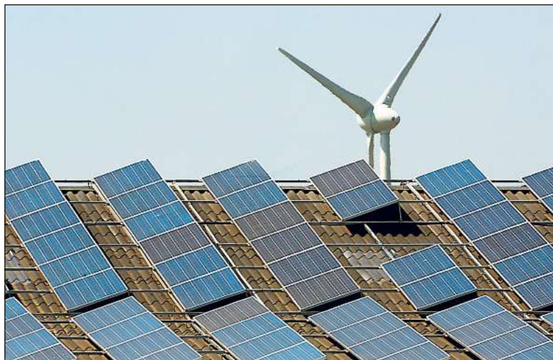
Einen sinnvollen Beitrag zum Umweltschutz will die Junge Union mit ihrem Antrag, auf städtischen Gebäuden Photovoltaikanlagen zu errichten, leisten. Bild: dpa
