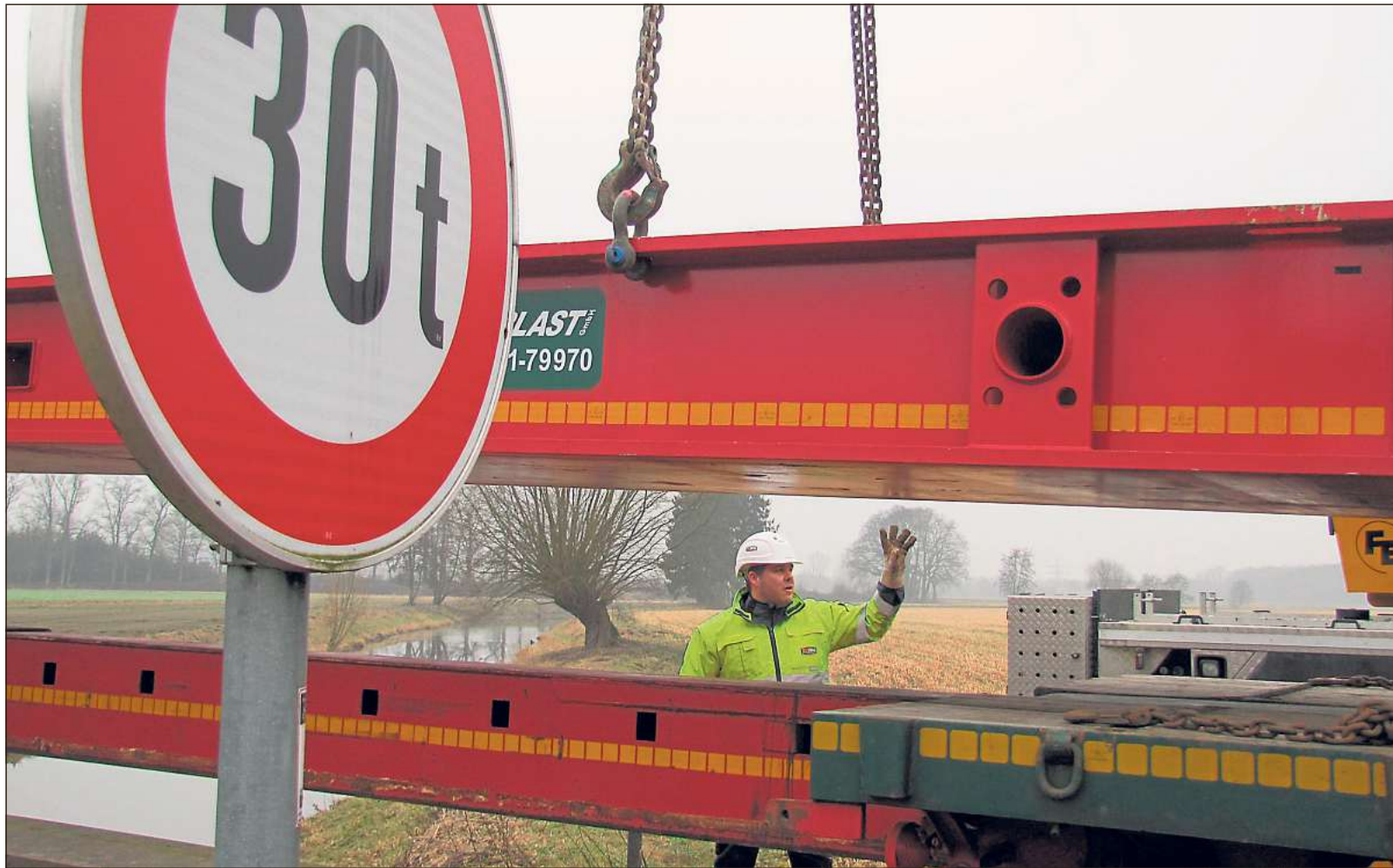
Viel zu wenig: Bis ums Vierfache werden die Schwerlasttransporte mit Windradteilen die maximale Belastbarkeit der Emsbrücke übersteigen. Das machte eine Zusatzkonstruktion am Maaßfeld erforderlich. Bilder: Wassum
