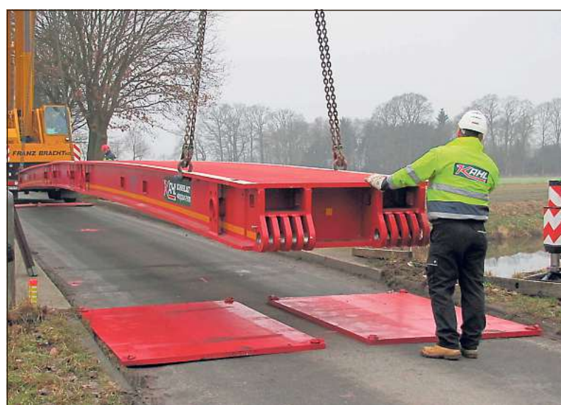
Auf voller Länge überspannen die Stahlkonstruktionen die Emsbrücke am Maaßfeld und nehmen die ganze Last auf.
