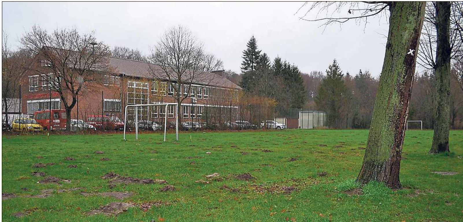
Heimat auf Zeit: Auf dem Bolzplatz am Lattenbusch neben der St. Viter Feuerweherschule soll in den kommenden Wochen eine Unterkunft für 60 Flüchtlinge errichtet werden. Ähnliche Wohnpavillons sind auch andernorts im Rheda-Wiedenbrücker Stadtgebiet geplant. Bilder: Heft
