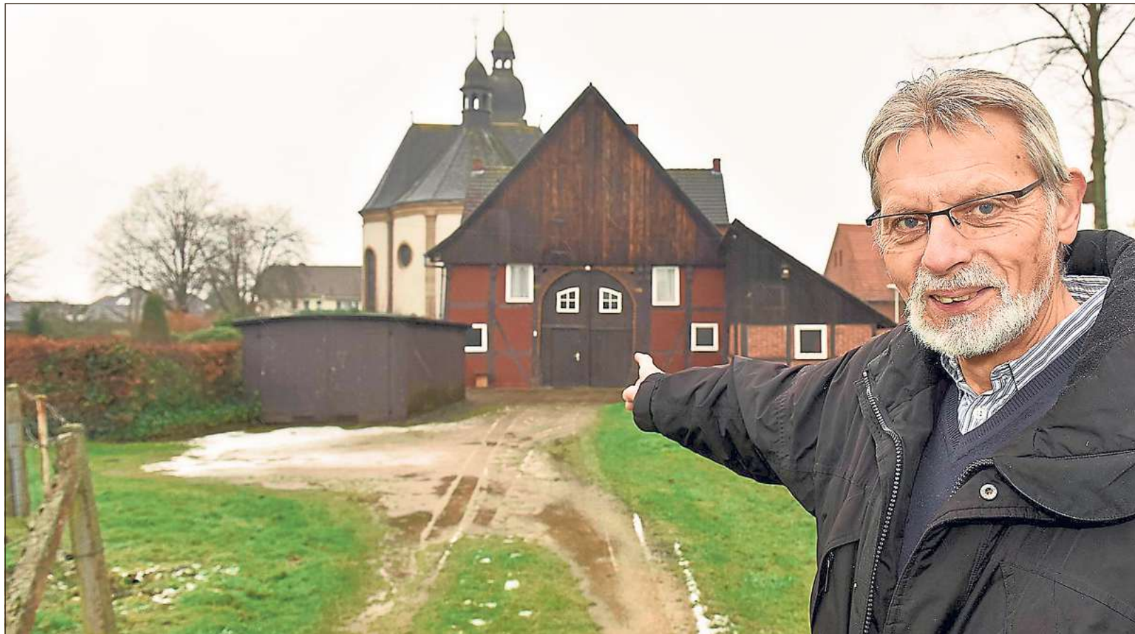
Genauso wie die dahinterliegende Pfarrkirche gehört das Küsterhaus zum St. Viter Ortsbild. Für Hermann Josef Budde von der Interessensgemeinschaft Küsterhaus ist klar, dass das markante Gebäude auf jeden Fall erhalten bleiben muss.
