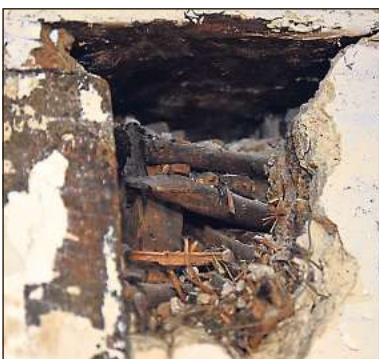
Das freigelegte Mauerwerk zeigt den Stützbalken, der mit Weidenholz umflochten wurde.
